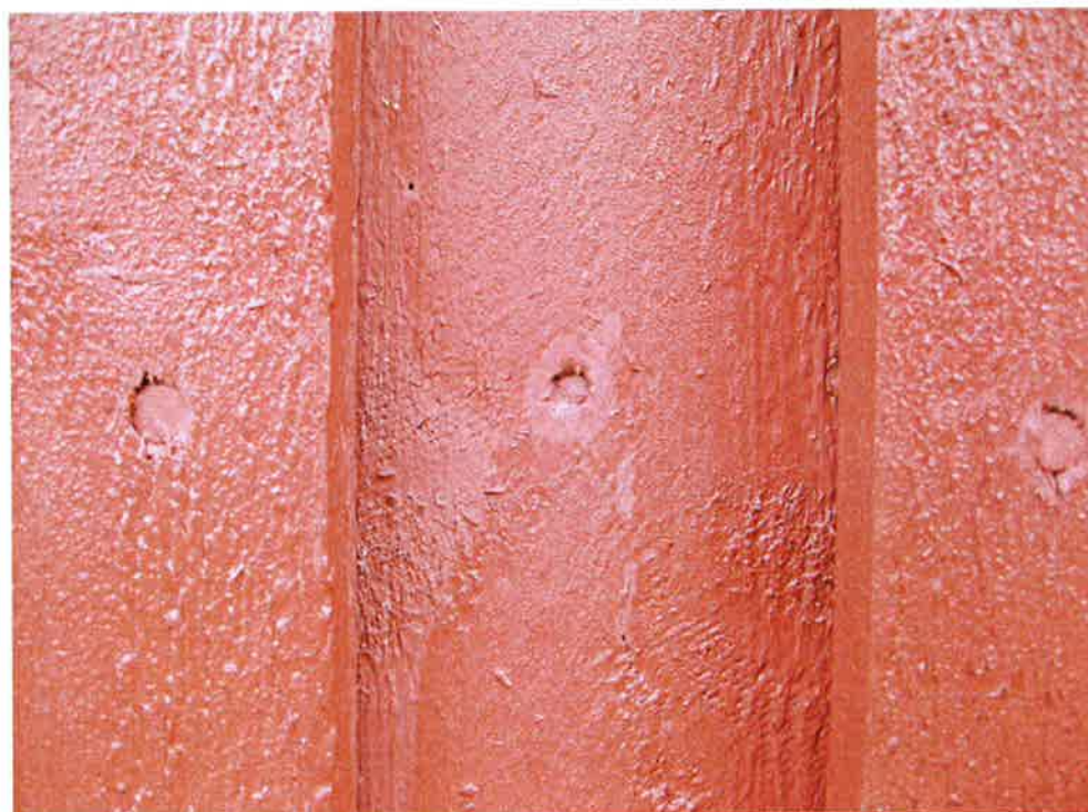
Figur 27 Försök till bättring av ytbehandlingen kring spikhål. Svårt att få samma nyans.
