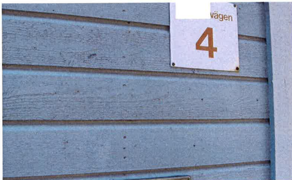
Figur 22 Liknande vertikal spikrad där några spik sitter i liv med pannelsytan, vilket förstärker intrycket av de djupa spikhålen.
