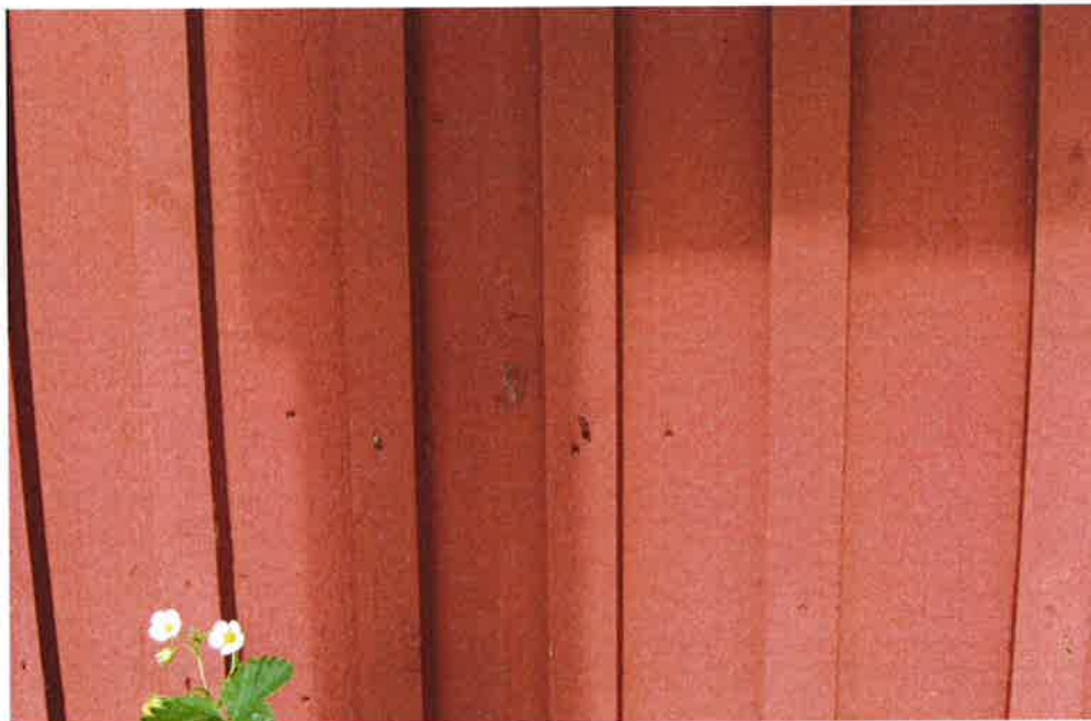
Figur 19 Några få, djupa spikhål i en lokal grupp, ocentriska och dubbla i en locklist.
