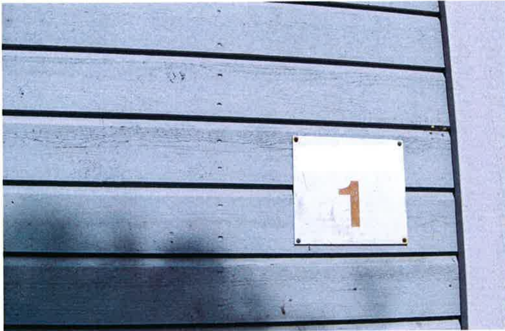
Figur 21 Djupa spikhål exakt i lod på horisontella panelbrädor. Avstånd till ovankant varierar dock, vilket syns tydligt.
