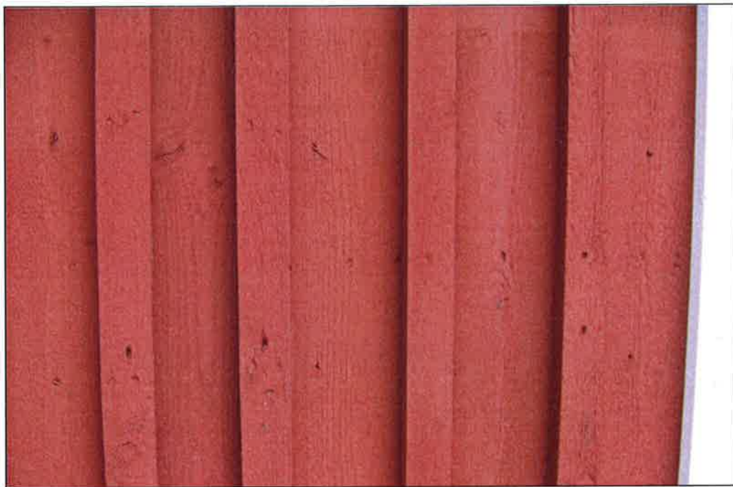
Figur 15 Spikrader på olika höjd i olika stående panelbrädor syns tydligt om spikhålen syns.
