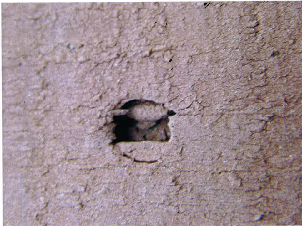
Figur 41 Mycket djupt spikhål med flagor av färg som delvis täcker hålet och förstärker djupintrycket.
