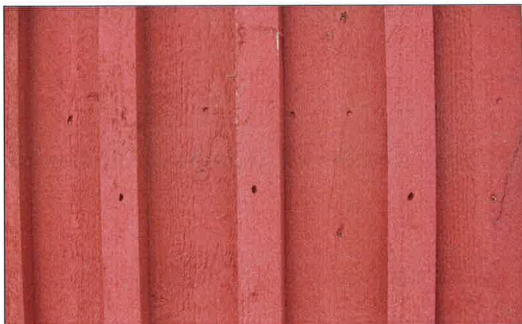
Figur 13 Flera extra spikar i vissa bottenbrädor som syns tydligt på grund av spikhålen. Ett par ”spikar” verkar vara popnitar. Spikhålen i locklisterna är extra djupa.
