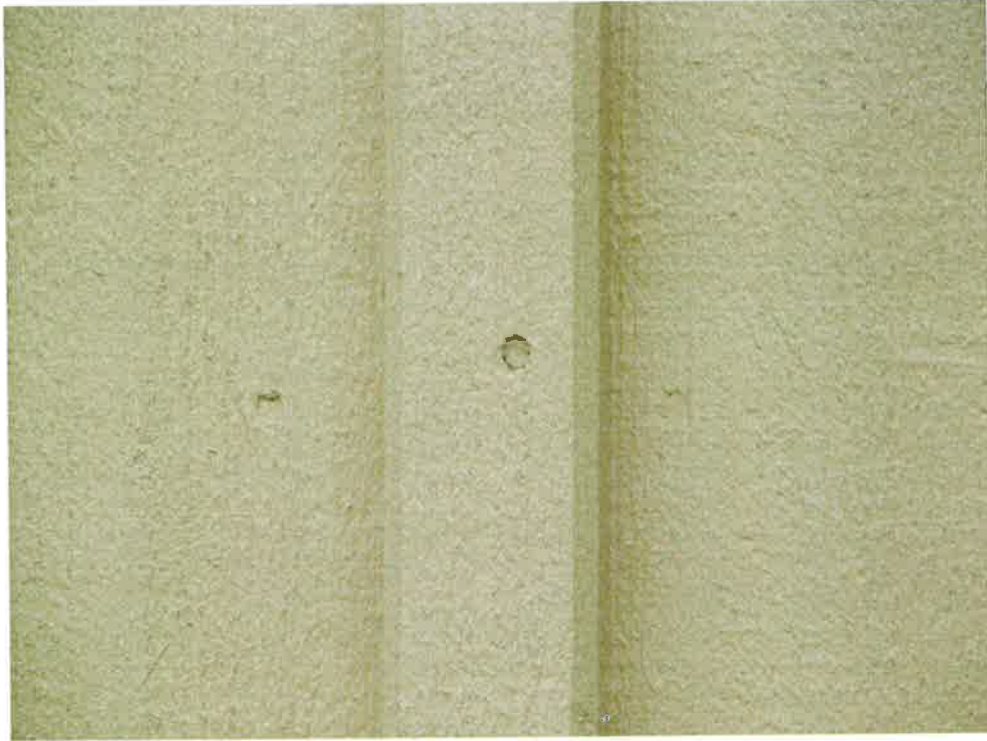
Figur 32 Grunt spikhål, ocentriskt på locklist med fasade kanter. Intelligande spik i bottenbrädorna syns knappt.
