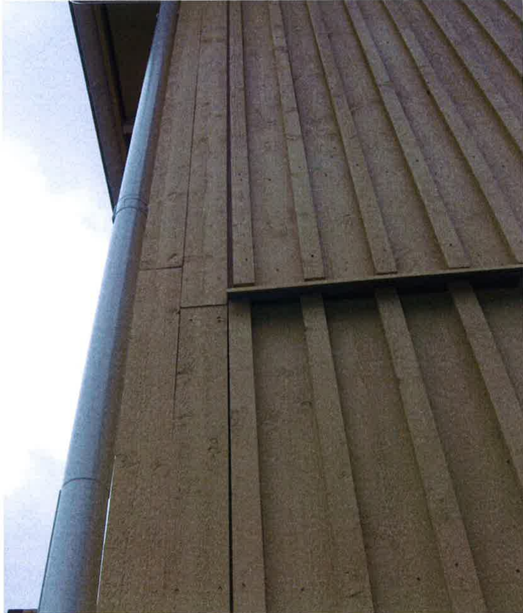
Figur 11 Djupa spikhål markerar tydligt spikens placering i förhållande till t ex ändskarvar. Spikhål som inte sitter centriskt på en smal locklist syns extra tydligt.
