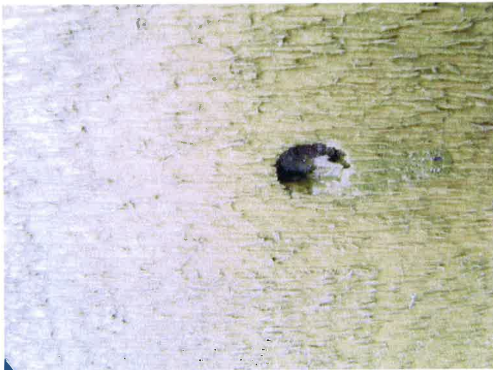
Figur 38 Mycket djupt spikhål i liggande panel.
