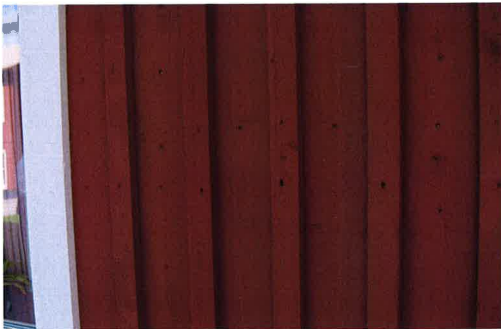
Figur 17 Djupa spikhål som avslöjar extra, ocentriska spik i locklister och bottenbrädor.
