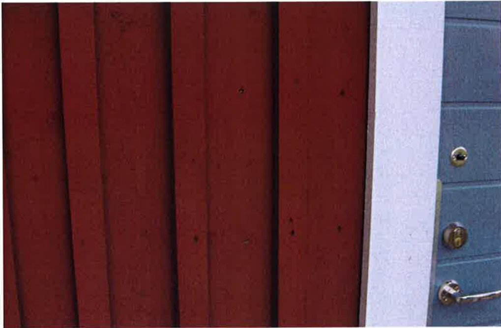
Figur 14 Extra djupa spikhål i locklisterna, inte alltid centriskt och ibland dubbelt. Extra spik i bottenbrädorna, ibland vertikalt, ibland horisontellt.
