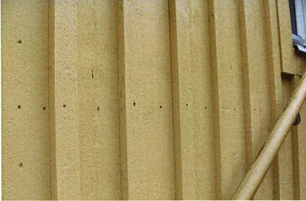
Figur 9 Djupa spikhål på en ojämn horisontell rad. Några extra spikar på vänstra bottenbrädan som verkar vara omotiverade.
