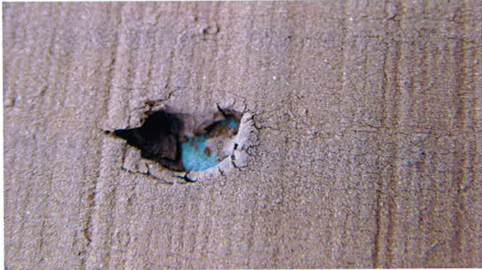
Figur 40 Mycket djupt spikhål med egendomliga skador i färgskiktet
