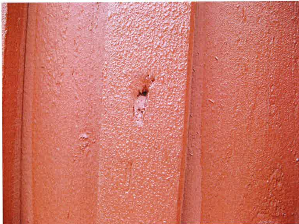
Figur 29 Liknande söndertrasad panel över och under spikhål.
