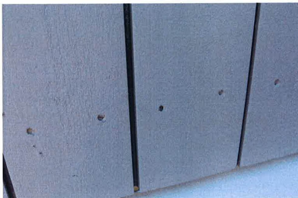
Figur 4 Parvisa spikhål där något spikhål är extra djupt
