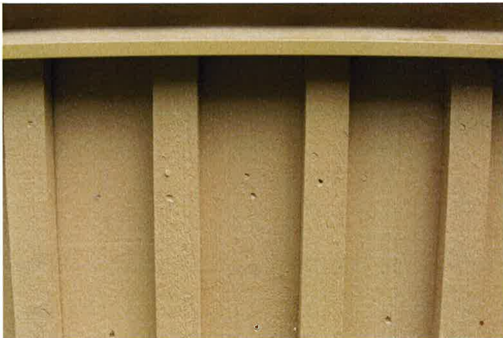
Figur 10 Spikhål som sitter ojämnt i höjdlid och inte alltid centriskt. Några spikar är inslagna exakt i nivå med panylytan medan någon t o m inte är tillräckligt inslagen.
