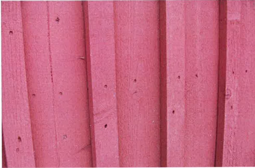
Figur 16 Djupa spikhål, flera extra i både bottenbrädor och i locklister.
