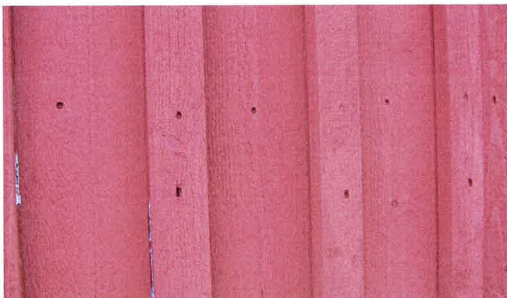
Figur 12 Djupt inslagna spikar, inte alltid centriskt i bottenbrädan. Extra spikar i djupa spikhål i flera av locklisterna.
