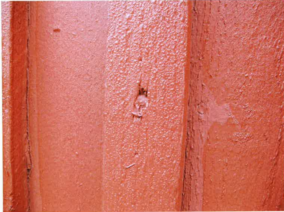
Figur 28 Söndertrasad panelyta över och under grunt spikhål.
