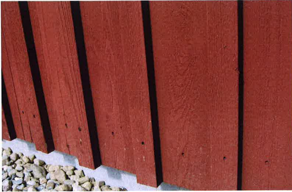
Figur 20 Mycket djupa spikhål en bit från nedre paneländar; två bottenbrädor ändå spruckna.
